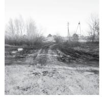
журнов) проведены работы по ремонту перехода - проведена отсыпка перехода гравием и асфальтовой крошкой
